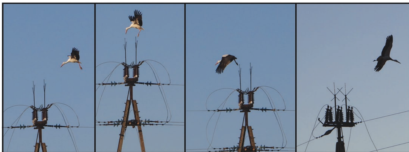
Rys. 6. Próba wylądowania młodego bociana na słupie SN z przewodami nieizolowanymi, która gdyby nie separator, zakończyłaby się śmiercią ptaka (K. Piwowarczyk) Fig. 6.
