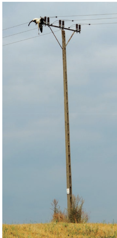
Rys. 1. Słup przelotowy linii SN z porażonym prądem młodym bocianem (fot. A. Zbyryt) Fig. 1.
