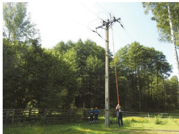
Rys. 5. Montaż separatora techniką PPN z odległości drążkiem izolacyjnym teleskopowym (A. Zbyryt) Fig. 5.
